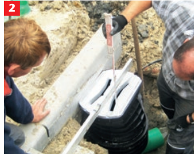
2 Optimale Ausrichtung des Ablaufs inkl. Aufsatz durch die Drehbarkeit, Teleskopierbarkeit und Anpassung an die jeweilige Quer- bzw. Längsneigung
