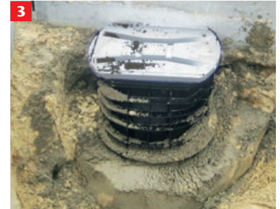
3 Unterteil auf Fundamentbeton C 12/15 versetzt und bis zur ersten Querrippe mit Rückstütze einbauen
