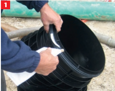
1 Vorbereitung der Oberteile durch Auftragen des Gleitmittels vor dem Ineinandersetzen
