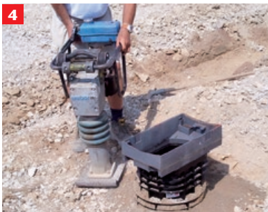
4 Verfüllen nach DIN EN 1610 mit entsprechendem Verfüllmaterial nach DIN 18196. Verdichten mit leichtem Verdichtungsgerät bis zur Markierung „Unterkante Beton“ auf dem obersten Kunststoffelement.
