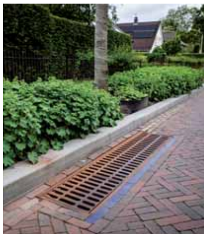
ExoDrain Kolk voorzien van scharnierende CorTen afdekking in Ellecom.
