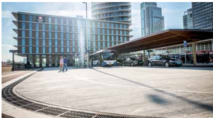
ExoDrain voorzien van Multiline gietijzeren sleufrooster met Drainlock® rondom busstation Amsterdam Amstel.
