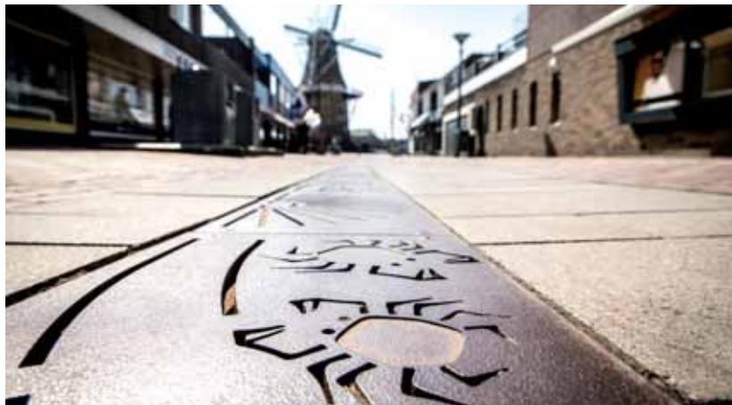
CorTen afdekking lasergesneden en laser gefreesd, custom made voor centrum Delfzijl
