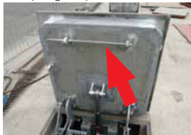
Noodopening luik met betonvulling
