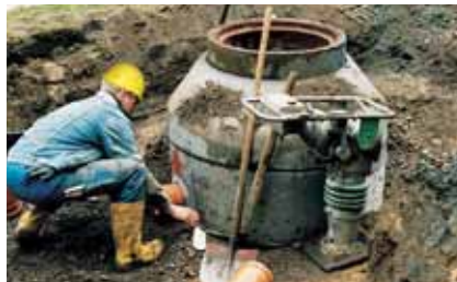
Eenvoudige montage van de aan- en afvoertleidingen aan de afscheider.
