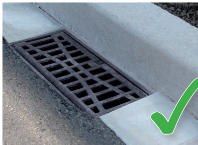
20 cm betonsteen langs asfalt
