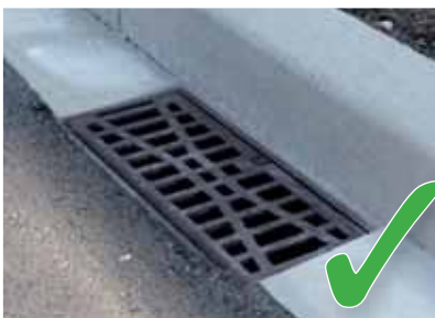
20 cm betonsteenstrek langs asfalt
