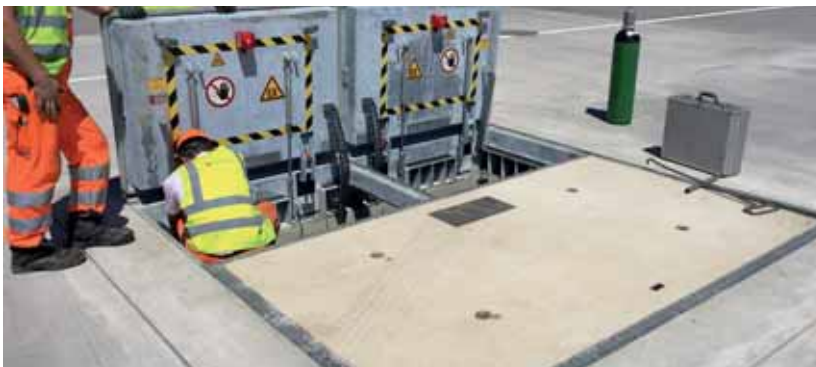
3-delige afdekking met twee inspectieopeningen. Belastingsklasse F900
