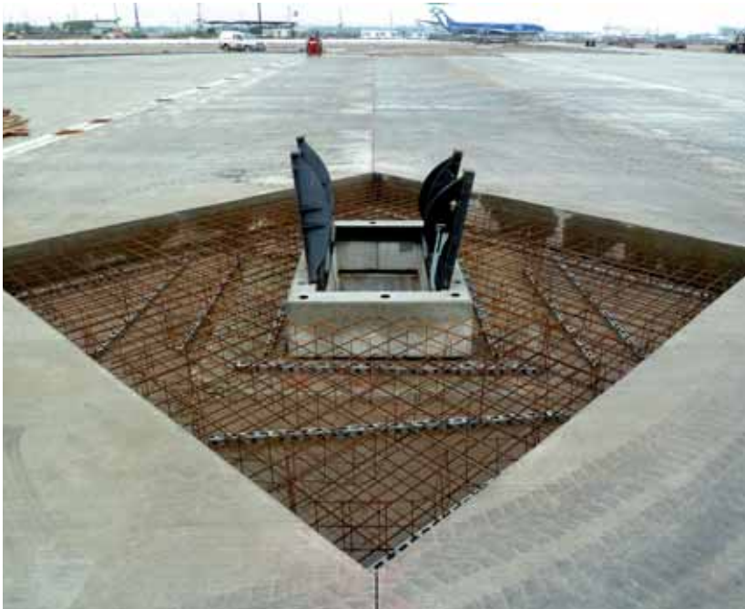
Kabelschachtafdekking met driehoeksdeksel in prefab betonrand
