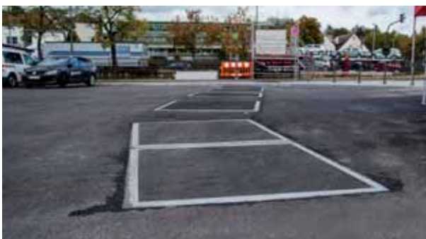
Terugstuwveilige afdekkingen met asfaltvulling.
