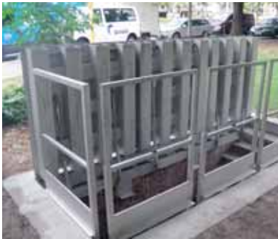
Driedelige afdekking met openingshulp en opklapbare uitzetbeveiliging.
