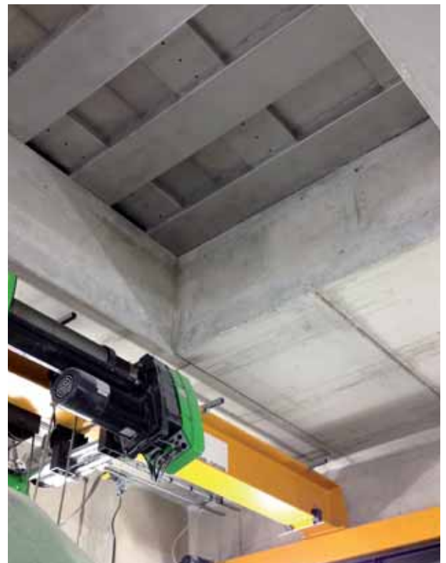
Overstromingsveilige afdekking op een montageopening (van onderaf gezien).
