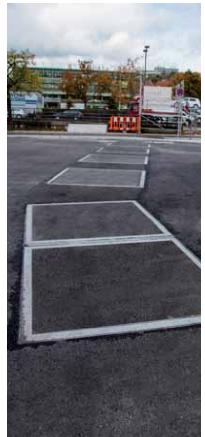
Terugstuwveilige afdekking met asfaltvulling.
