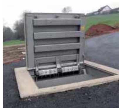
Afdekking met gasveer als openingshulp.
