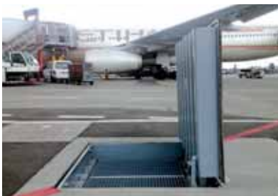
Luik voor zwaarbelaste verkeersoppervlakken zoals een vliegveld. Voorzien van invalbeveiliging. Belastingsklasse F900
