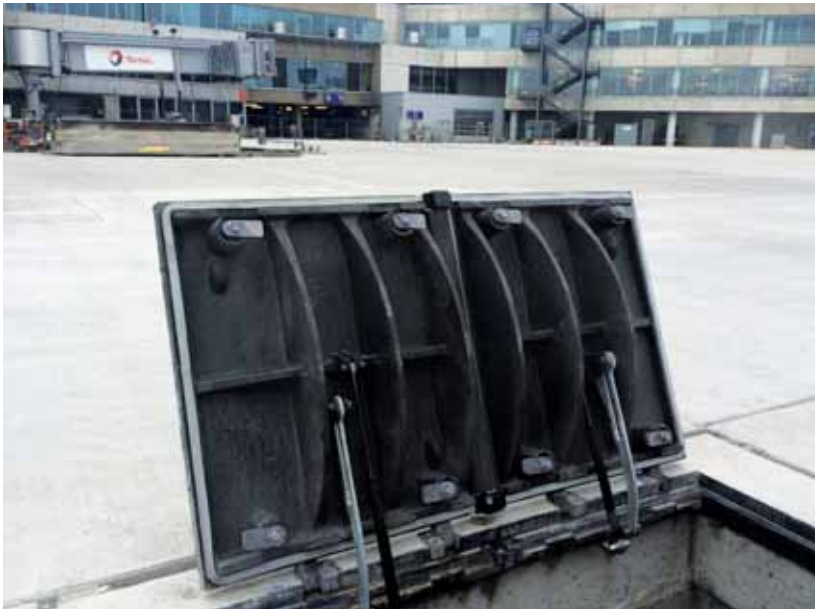
Kabelschachtafdekking, druiwaterdicht. Belastingklasse F900
