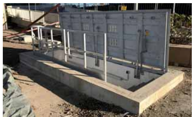
Beloopbaar toegangsluik met openingshulp.
