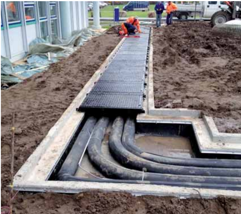
Kabelgootafdekking met gietijzeren luiken. Belastingsklasse B125
