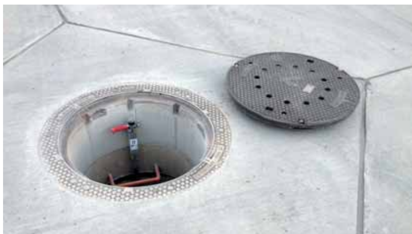
Verkneveld gietijzeren deksel. Belastingsklasse F900, dagmaat 800 mm.
