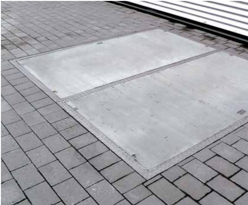
2-delige schachtafdekking met betonvulling
