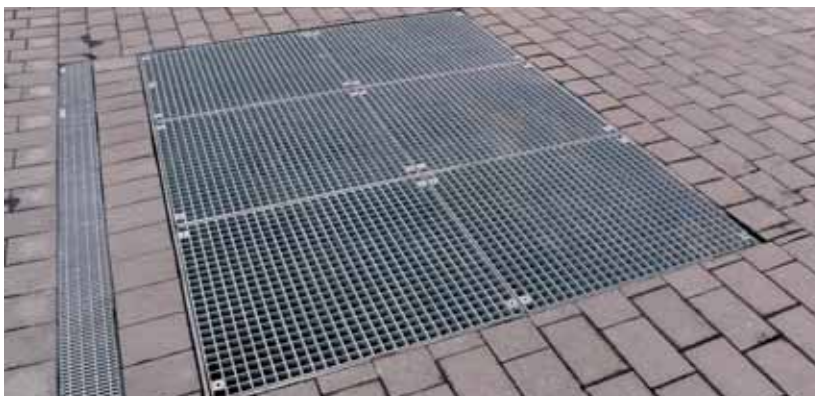
Schachtafdekking met 6-delig maasrooster.
