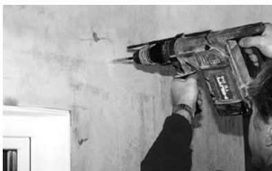
3. De beide bovenste gaten met diepteanslag (7 cm) boren. Let op: niet te diep boren!
