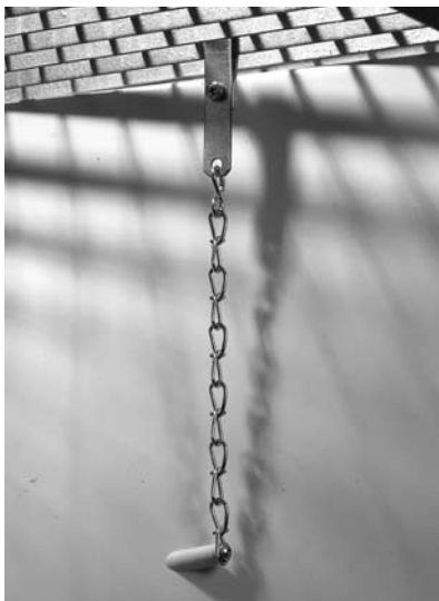
1. Lichtschachtrooster plaatsen en rooster-verankering vast schroeven.
