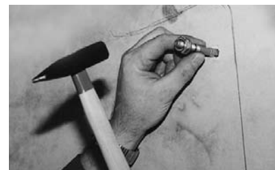
5. De beide bovenste slagankers/keilbouten inslaan.
