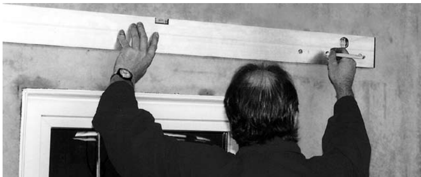
2. De plaats van de lichtschacht bepalen (bovenkant lichtschacht, midden van het raam) en met de montagehulp voor lichtschachten de beide bovenste gaten aftekenen (bovenkant montagehulp = bovenkant lichtschacht). De lichtschacht tegen de wand houden en het contour grof met een potlood markeren.
