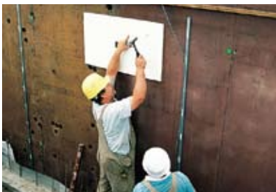
Prefab montageplaat op de bekisting bevestigen.
