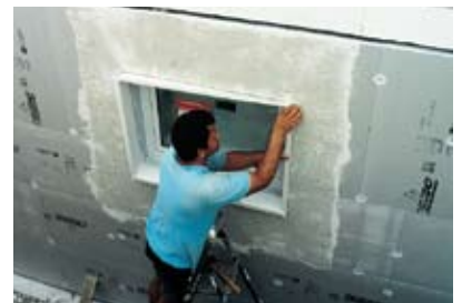
De in elkaar gezette isolatieaansluitprofielen na het aanbrengen van de muurbekleding in de, door het verwijderen van de bekistingafdichting ontstane, groef plaatsen.
