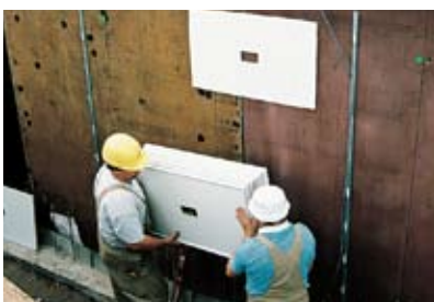
Het ACO Therm® kozijnkantstuk op de montageplaat zetten en met de aan het kozijnkantstuk aangebrachte ponsstroken zekeren.
