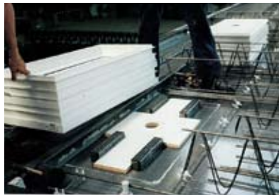
De montageplaten kunnen ter bevestiging met magneten gefixeerd worden resp. als totaalpakket op de ontvette bekisting geplakt worden. Hierdoor kan de wapening obstakelvrij aangebracht worden.
