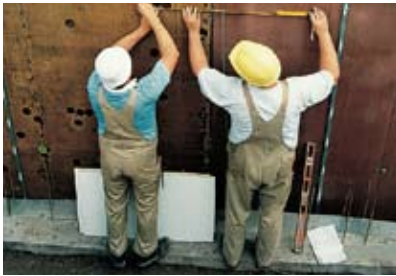
Positie van het kozijnkantstuk/montageplaat bepalen.
