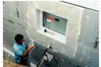
Het isolatieprofiel is op de bouwplaats zonder gereedschap gemakkelijk aan te passen op de gebruikte isolatiedikte van 100/80/60 mm of 110-200 mm.
