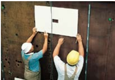
Prefab montageplaat op de juiste hoogte waterpas fixeren.
