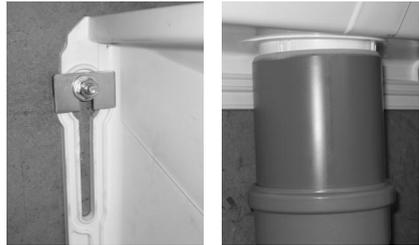
Den Rohrstutzen bis kurz unter den Lichtschachtboden schieben.
