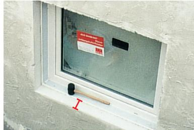
2. Dazu wird das Profil an der entsprechenden Sollbruchstelle mit einem Cuttermesser zwei- bis dreimal geritzt und abgebrochen. Soll nur ein 5 mm Streifen entfernt werden, bitte eine Zange zu Hilfe nehmen. Die Eckverbinder an der entsprechenden Stelle abschneiden.
